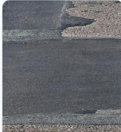
Edge breakage repair
