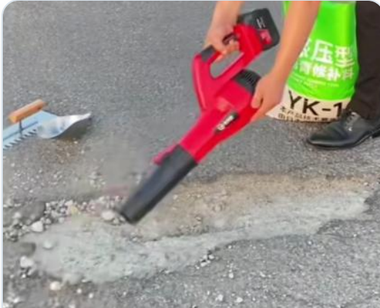
Clean damaged edge
